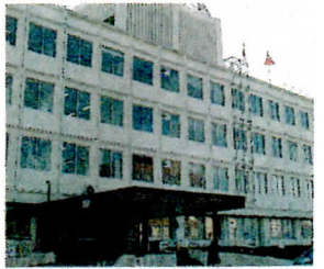
耐震改修工事が行われる県いわき合同庁舎
